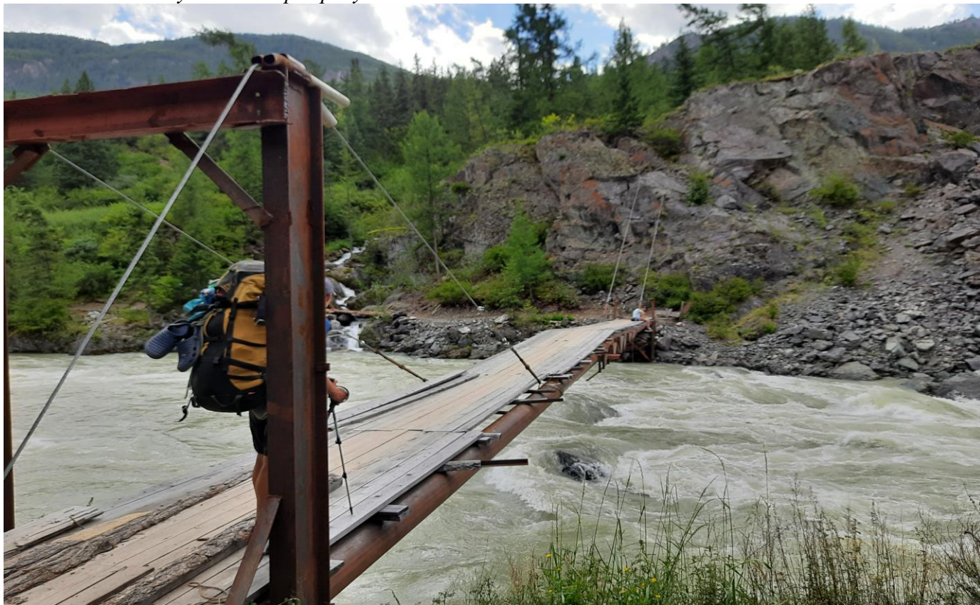
Фото 75. Мост через р. Чуя.
